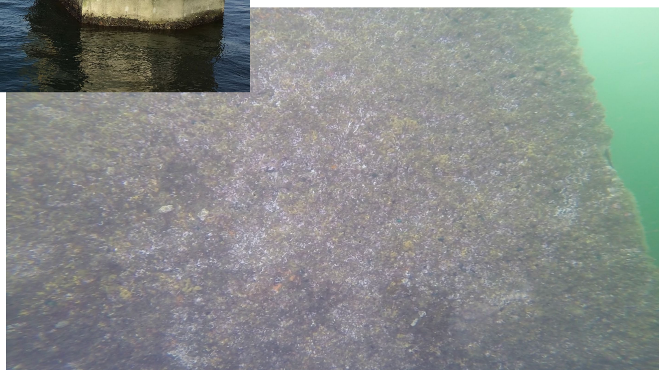
アクアブリッジの橋脚
